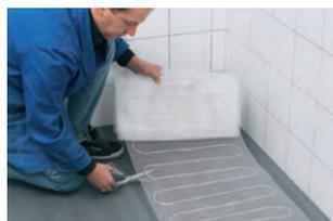
**02** Se a geometria da instalação o exigir, a esteira radiante pode ser dobrada.
